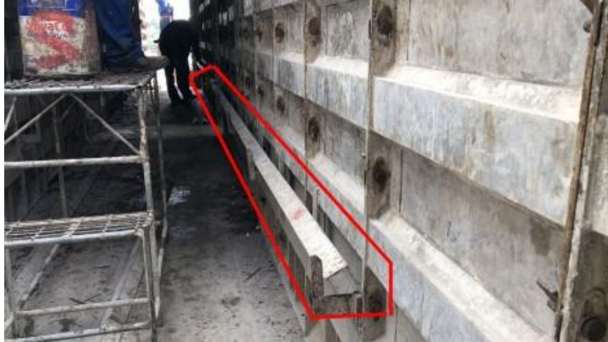
Figura 18 – Cantoneira de alumínio fixada nos painéis de parede, destacada em vermelho
