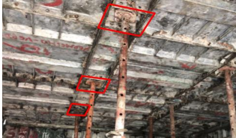
Figura 10 – Detalhe das ponteiros da laje com as escoras, destacadas em vermelho.
