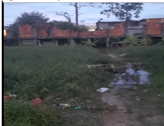
Figura 5: Construção Utilizada como Moradia Pelos Viciados
