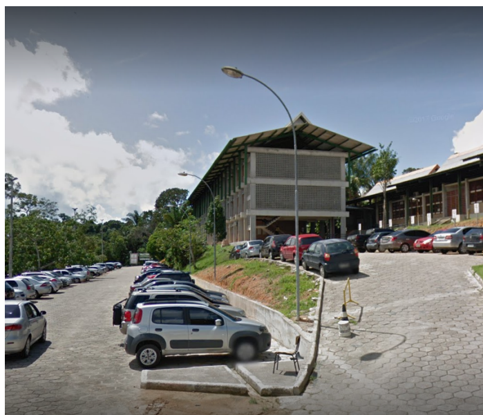
Figura 16 Área de circulação do estacionamento da Faculdade de Tecnologia
