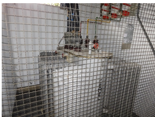
Figura 23 Transformador 500kVA
