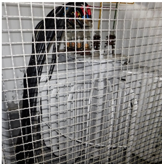
Figura 23 Transformador 500kVA
