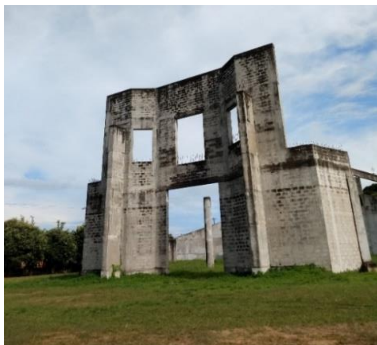
Figura 19 Igreja em construção. Fonte: Arquivo Pessoal
