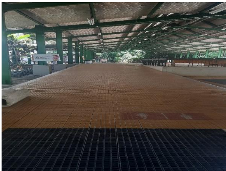
Figura 2 – Corredor de acesso principal à BSSN
