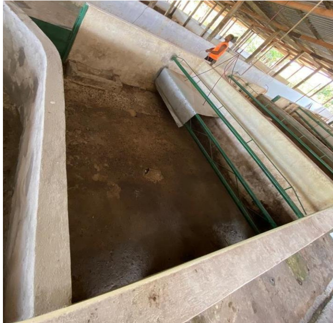
Figura 24 - Baia após limpeza e desinfecção
