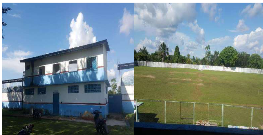
Figura 1. Visão Externa e Interna do Estádio Municipal José Henrique de Oliveira.
