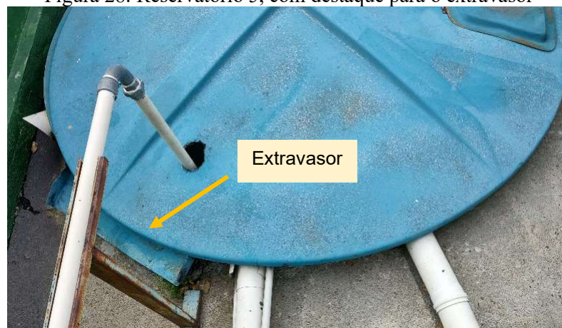
Figura 28: Reservatório 5, com destaque para o extravasor
