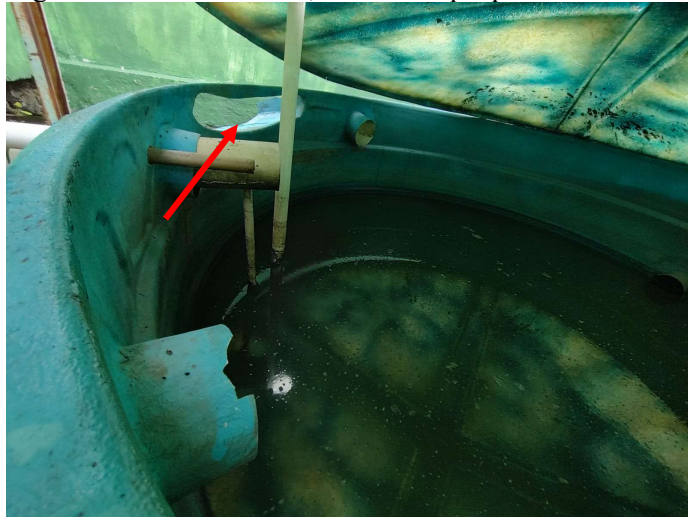
Figura 36: Reservatório 5, com destaque para o extravasor
