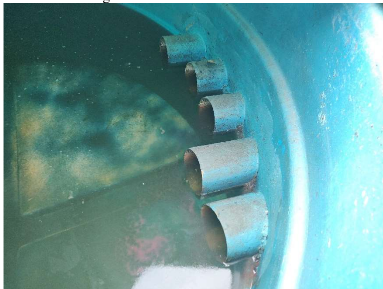
Figura 24: Interior do reservatório 1
