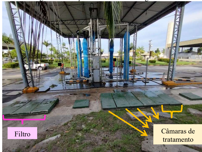
Figura 32: Estação de tratamento de esgoto local
