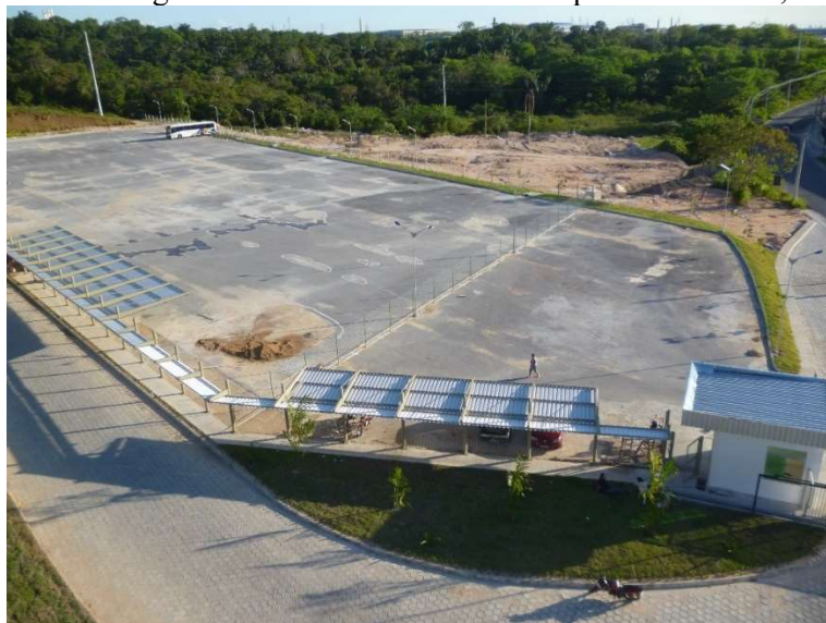
Figura 12: Vista geral dos estacionamentos da empresa em estudo, em 2012
