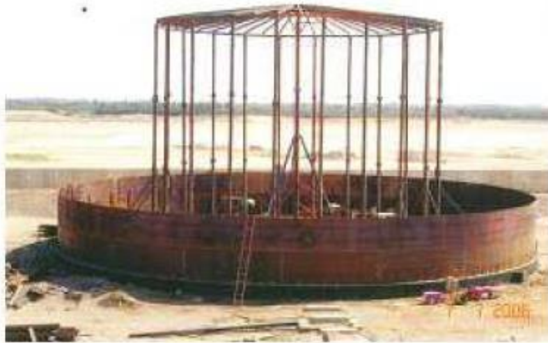
Figura 5: Tanque de teto fixo cônico suportados
