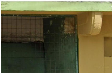
Figura 69 - Descamação da Textura.
