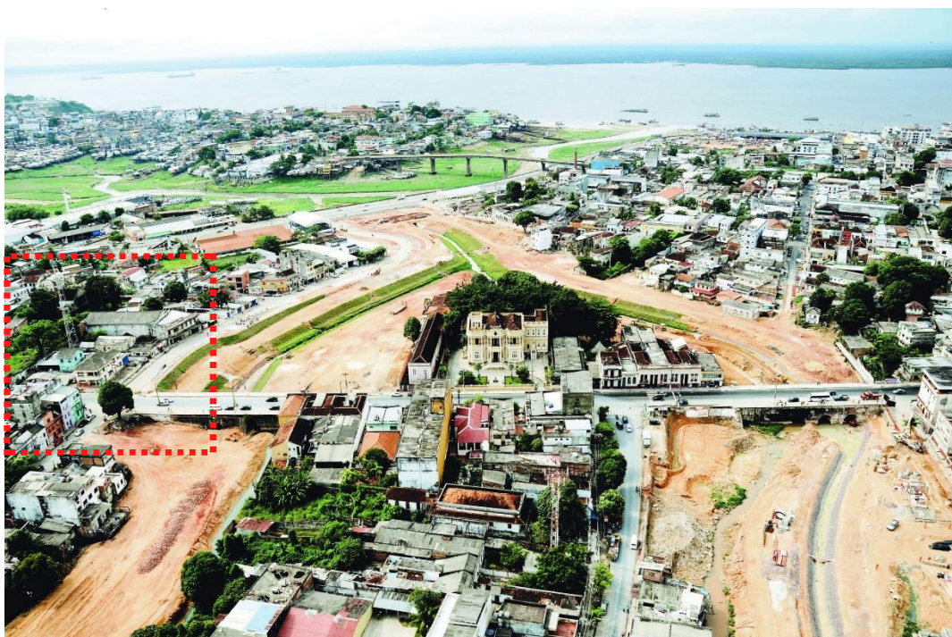
Figura 36 - Obras de aterramento e revitalização realizadas pelo PROSAMIM, em 2008. Ao fundo, a ponte Padre Antônio Plácido, à esquerda o entorno imediato do lote de projeto. Foto: Mario de Oliveira. Acervo: Agecom.
