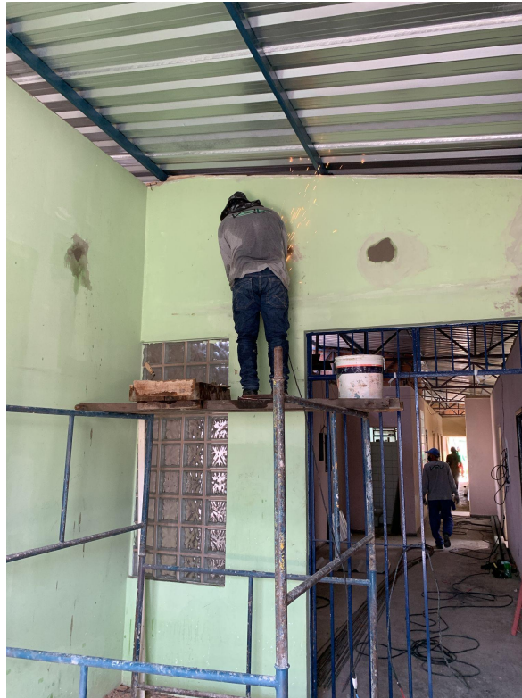
Figura 3 - corte em alvenaria para execução de instalações elétricas em 21.03.2023
