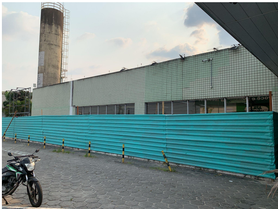
Figura 4 - Área com tapume para retirada de revestimento
