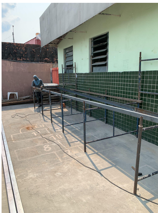
Figura 2 - Execução de estrutura metálica em 21.03.2023
