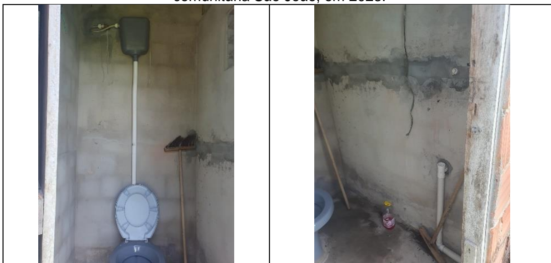
Figura 15: Vista do interior dos lavabos públicos existentes na sede da associação comunitária São João, em 2023.
