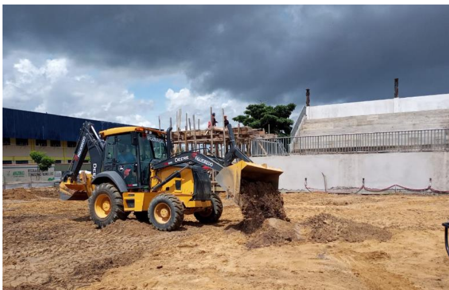
Figura 6 – Retroescavadeira realizando espalhamento do aterro.
