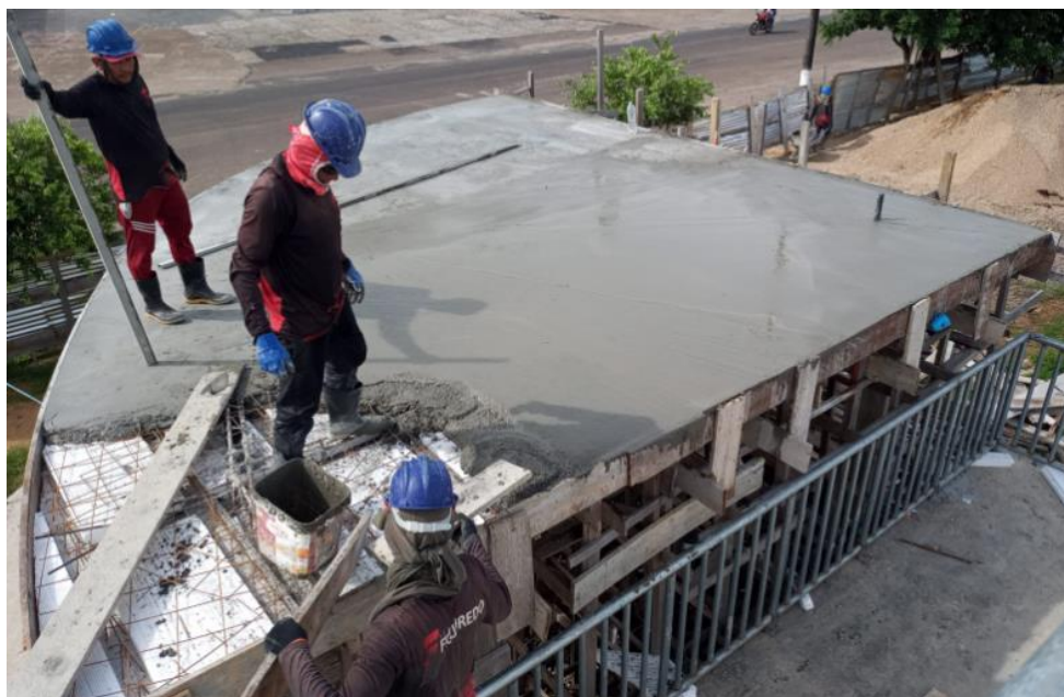
Figura 15 – Concretagem de laje pré-moldada.
