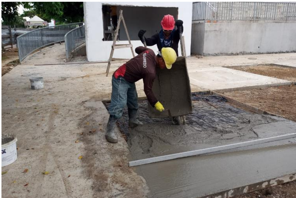
Figura 10 – Concretagem das placas do piso da quadra.
