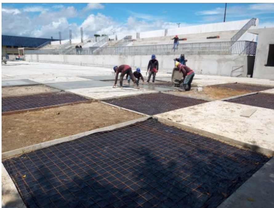
Figura 9 – Colocação da tela soldada e lona de impermeabilização.
