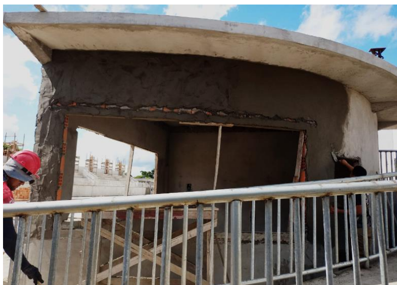
Figura 13 – Emboço de alvenaria.
