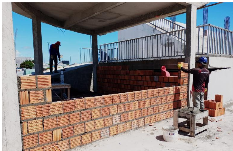
Figura 12 – Alvenaria de vedação com blocos cerâmicos.
