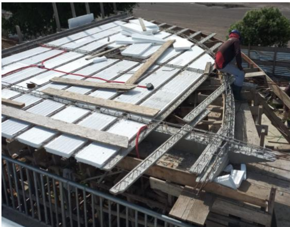
Figura 14 – Montagem de laje pré-moldada.
