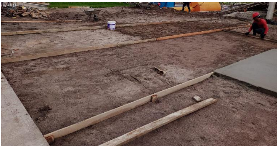
Figura 8 – Moldagem das placas de piso da quadra.
