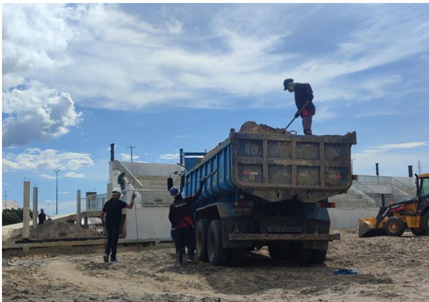
Figura 5 – Cubagem de material de solo para aterro.
