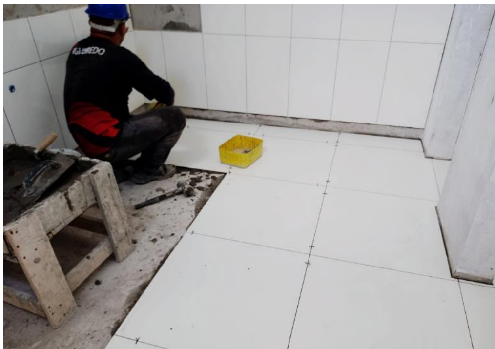
Figura 11 – Aplicação de revestimento cerâmico.
