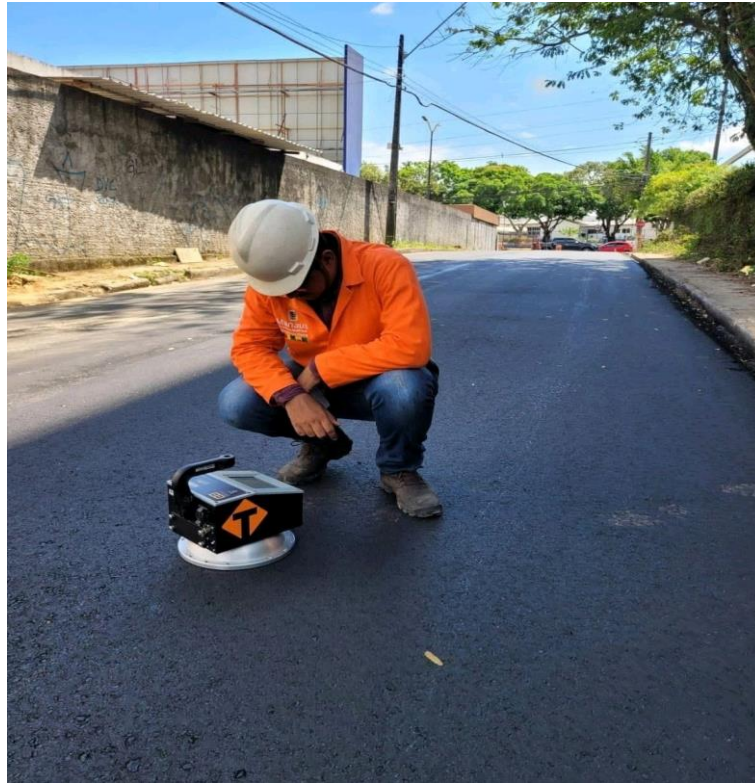
Figura 4: Execução do ensaio de densidade in situ
