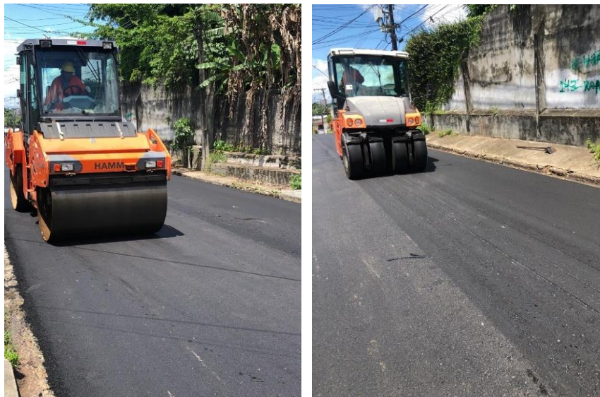
Figura 09: Compactação do pavimento pelos compactadores de chapa e pneumáticos.
