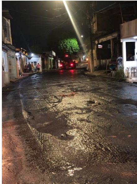
Figura 07: Pavimento com pintura de ligação.
