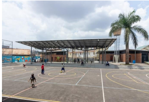
Figura 22 - : Quadra esportiva do Centro Comunitário Kamwokya
