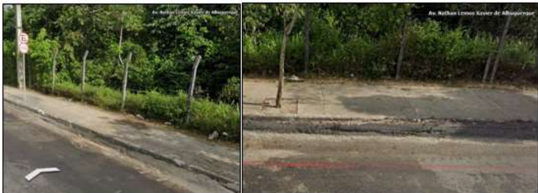
Figura 17 - Escorregamento, sentido Parque 10 - Novo Aleixo
