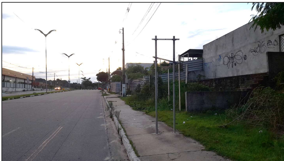
Figura 21 - Suporte de sinalização vertical furtada que indicava final da ciclofaixa
