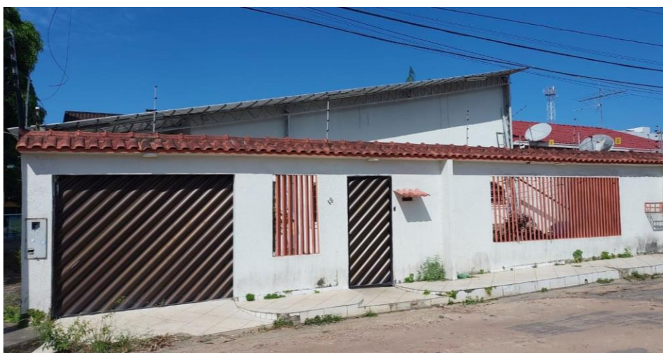
Figura 3 — Fachada da residência
