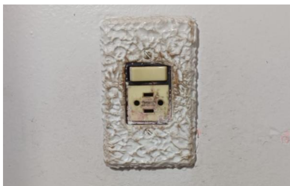
Figura 13 — Ponto de tomada com interruptor instalado
