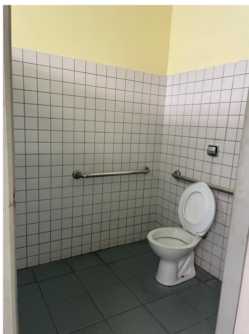
Figura 19 - Foto da Arena Amadeu Teixeira, Bwc's e Vestiários. Fonte: Acervo da Autora.
