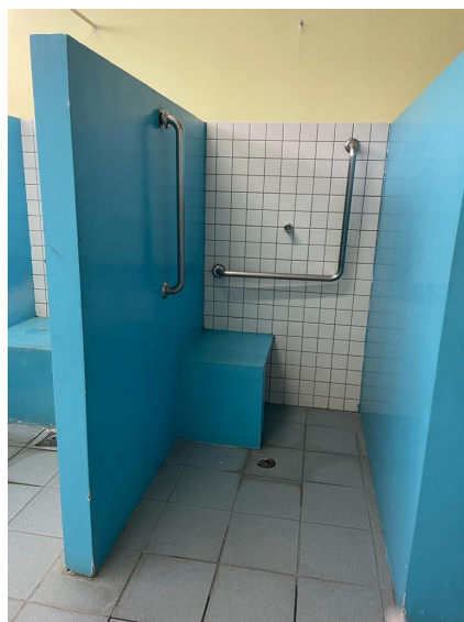
Figura 18 - Foto da Arena Amadeu Teixeira, Bwc's e Vestiários. Fonte: Acervo da Autora.
