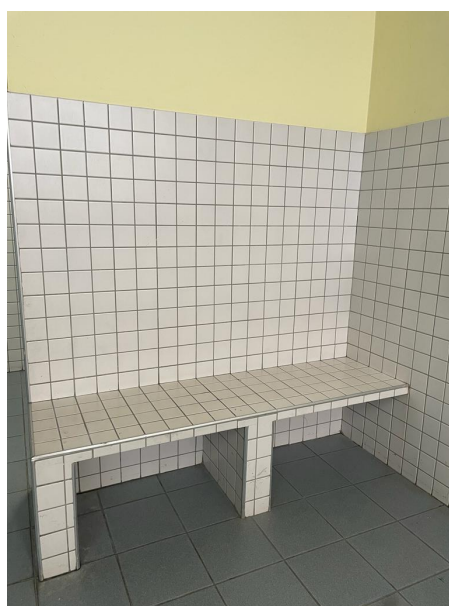
Figura 17 - Foto da Arena Amadeu Teixeira, Bwc's e Vestiários. Fonte: Acervo da Autora.
