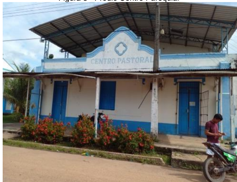
Figura 3 - Prédio Centro Paroquial
