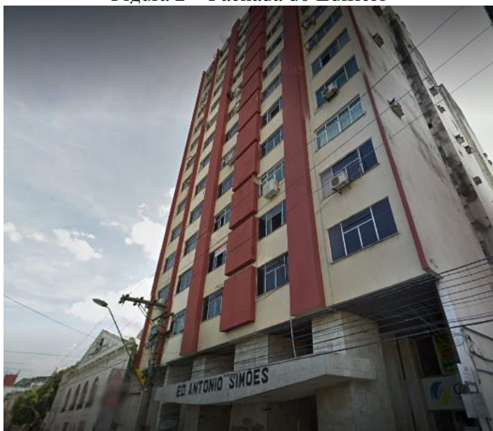
Figura 2 – Fachada do Edifício
