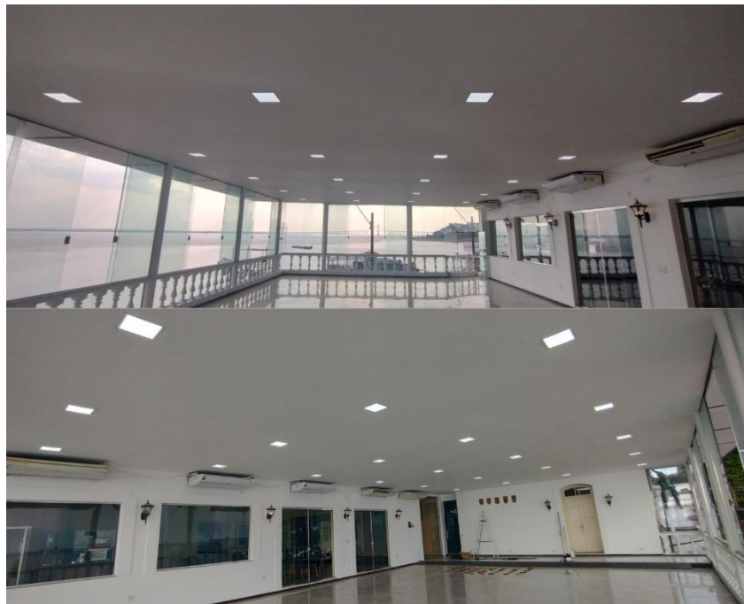
Figura 16. Finalização da Obra.
