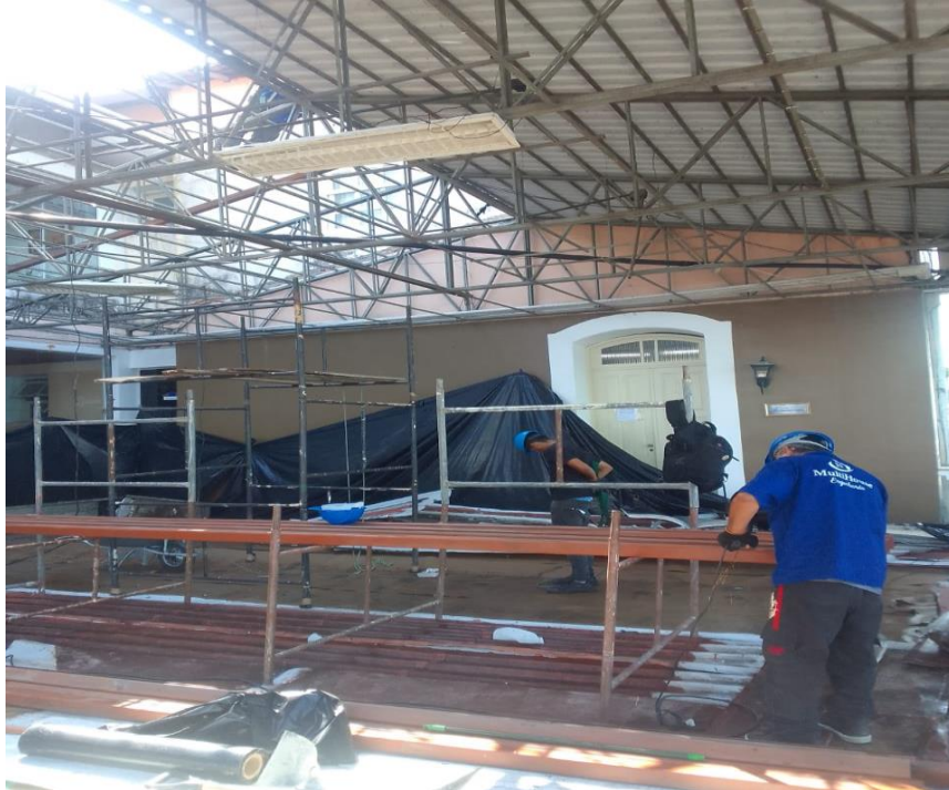
Figura 11. Central para soldagem e pintura de perfis metálicos.
