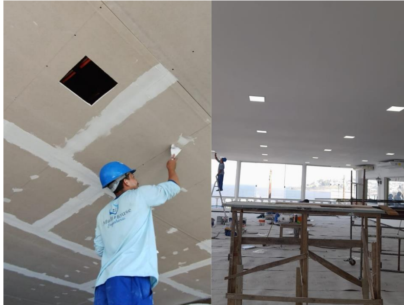
Figura 15. Corte no forro e instalação das luminárias.
