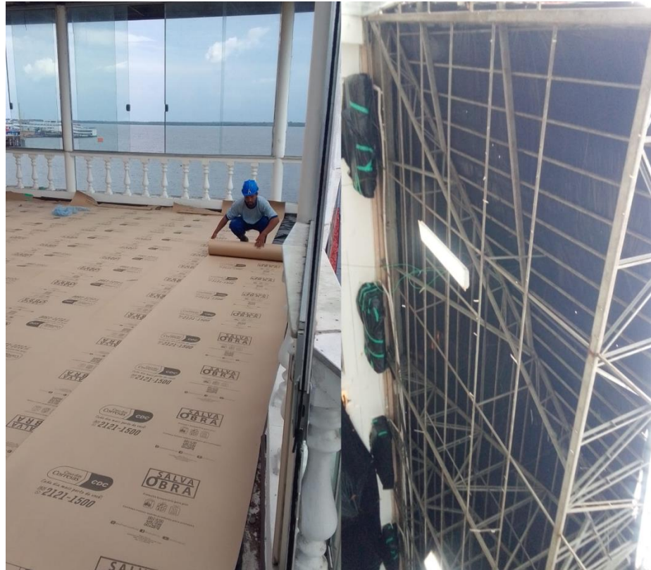
Figura 10. Proteção do piso e retirada do forro em PVC.
