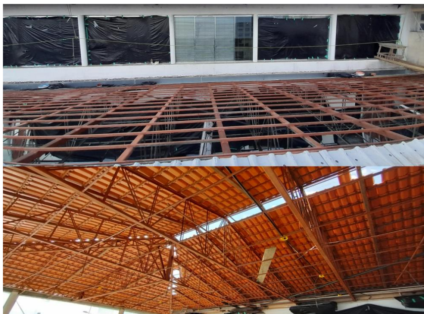
Figura 12. Retirada das telhas metálicas e encaixe das telhas cerâmicas.
