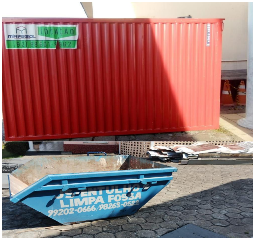
Figura 9. Locação de caixa de entulho e container para início das obras.
