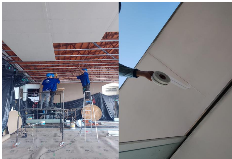
Figura 14. Montagem do forro e acabamentos.
