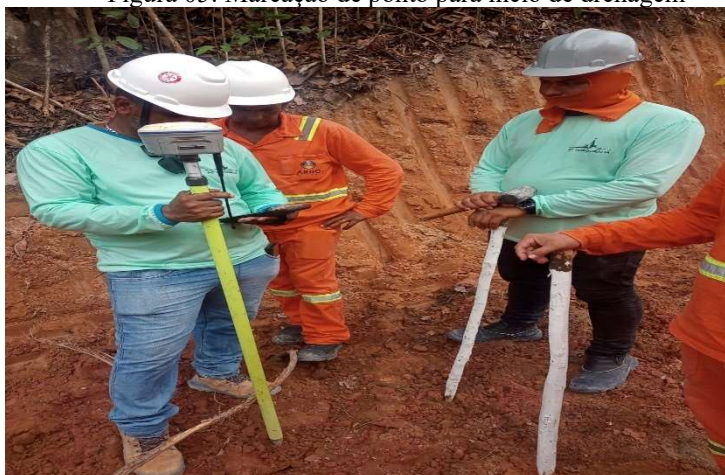
Figura 05: Marcação de ponto para inicio de drenagem
