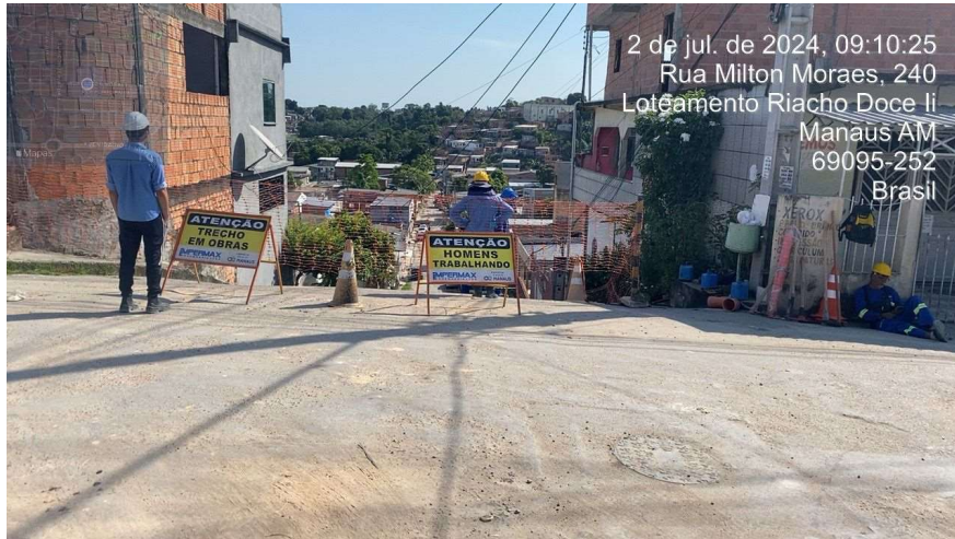
Figura 3: Sinalização do canteiro de obras
