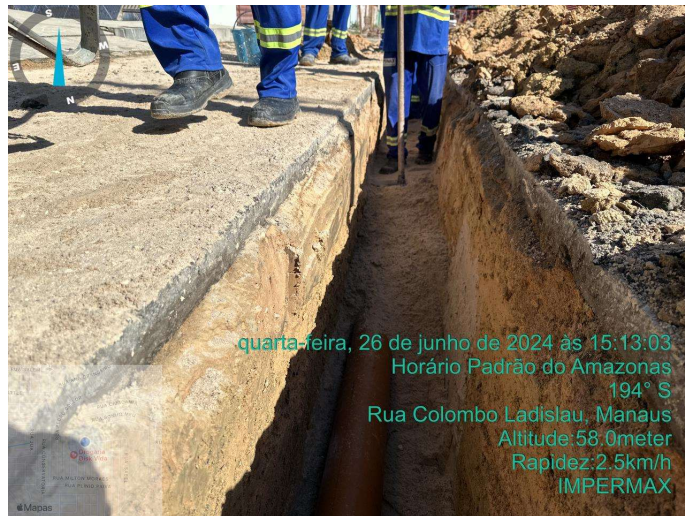
Figura 4: Assentamento de tubulação
