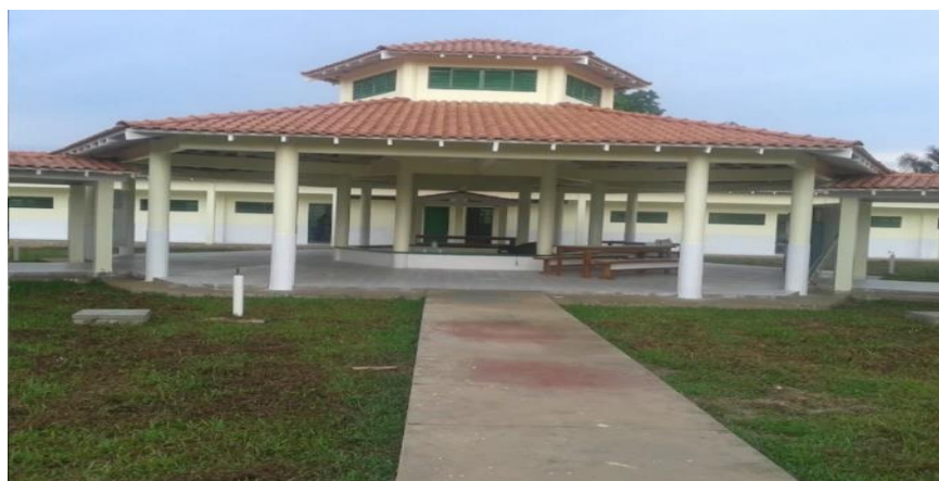
Figura 3: Fachada da Escola Estadual Indígena
