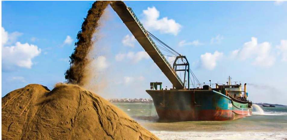
Figura 1 – Dragagem da areia no leito de rio
