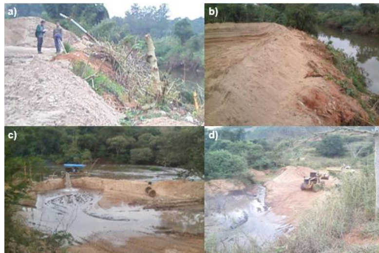
Figura 2 – Processo de extração da areia, a) e b) Fase de instalação e c) e d) Operação
