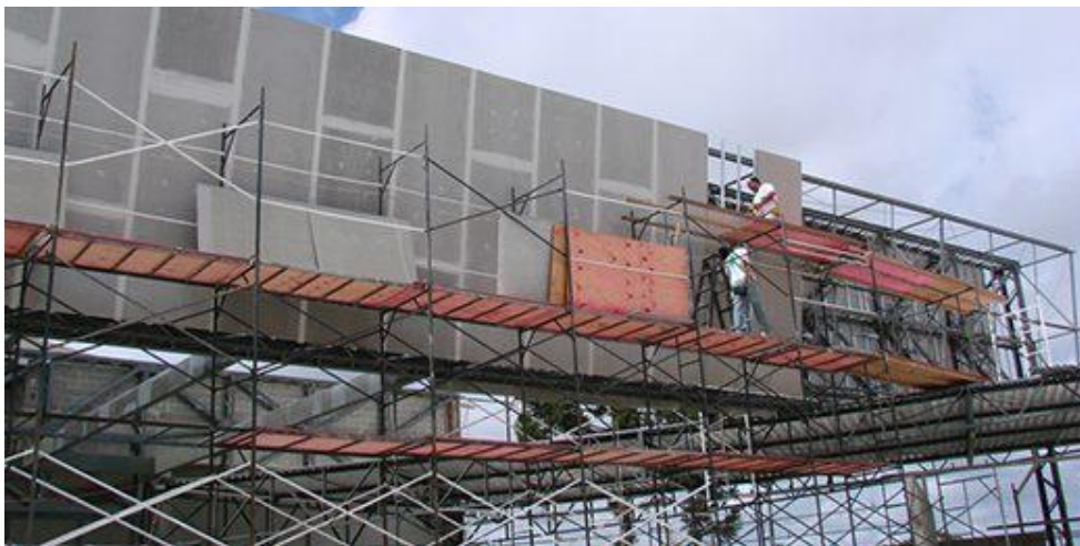
Figura 6 – Placas cimentícias, processo de montagem.
