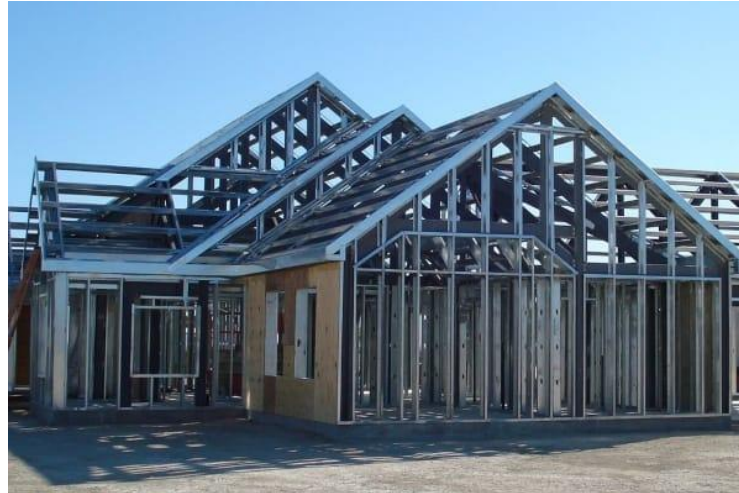
Figura 8 – Estrutura metálica do LSF.
