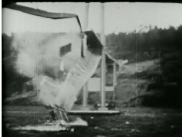
Figura 2 – Colapso da ponte Tacoma Narrows em 1940
