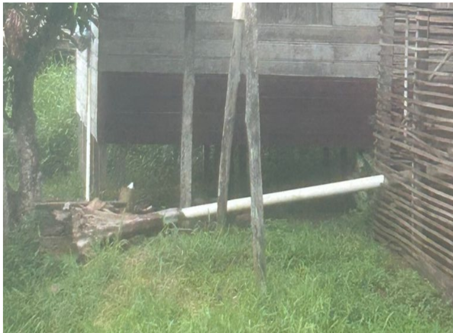
Figura 6: Coleta imagens esgotamento sanitário: Bairro Bom Jardim
