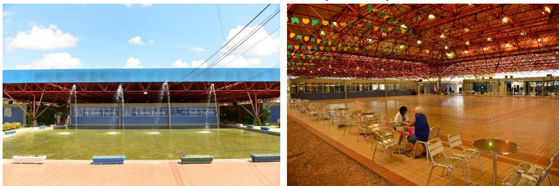
Figura 16 - Fachada do Centro de Convivência Pe. Pedro Vignola (à esquerda) e área de convivência (à direita).
