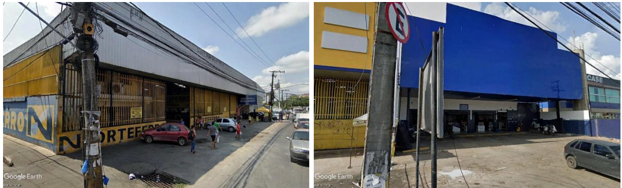
Figura 53 - Edificações comerciais características da tipologia do entorno localizadas na Av. Francisco de Queiroz e na Av. Max Teixeira, respectivamente.
