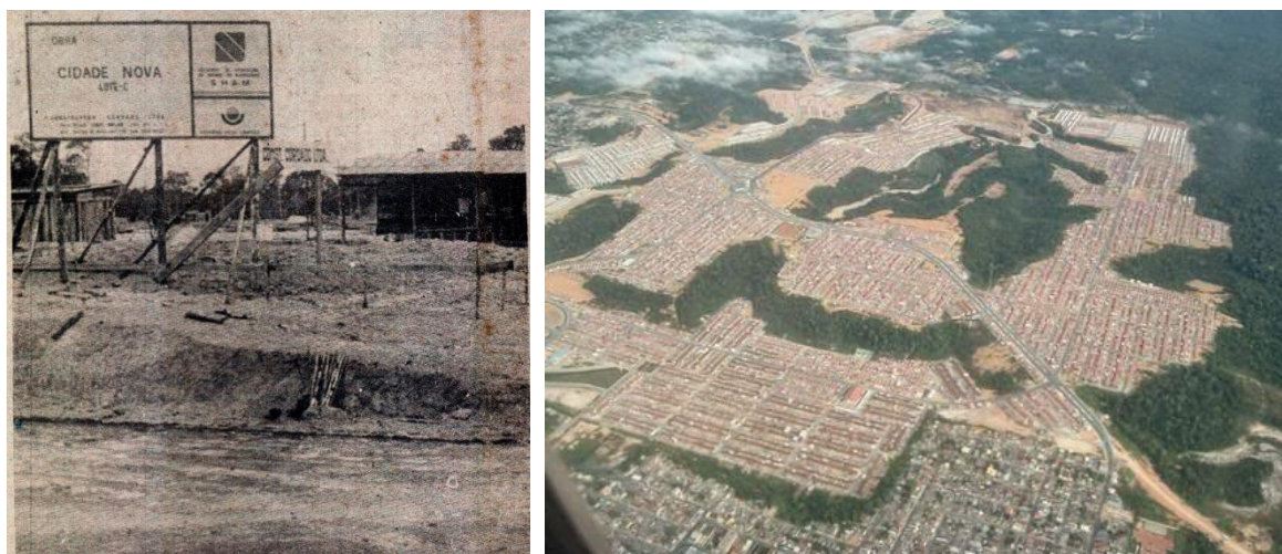
Figura 45 - Placa de construção do conjunto Cidade Nova (à esquerda) e vista área do conjunto (à direita).
