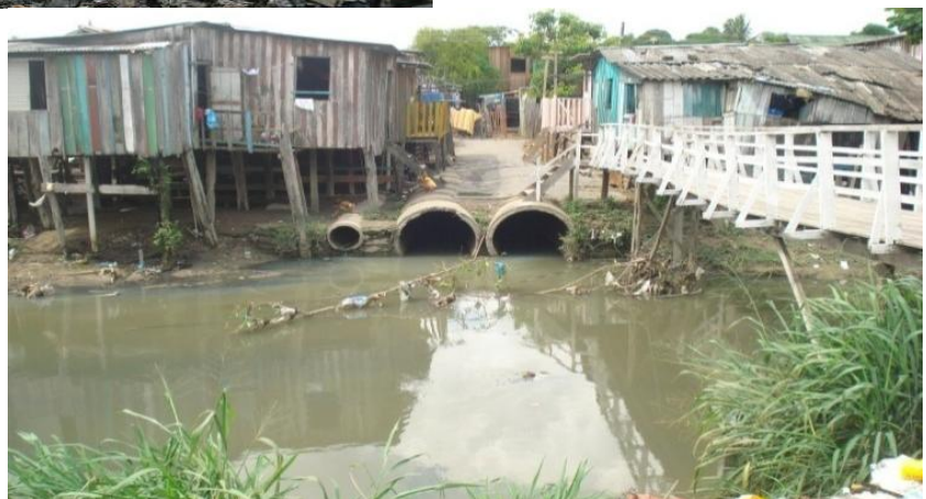
Figura 06: Trechos da Degradação Ambiental no Igarapé do Quarenta. Fonte: Secretaria Municipal de Meio Ambiente, dezembro de 2009.
