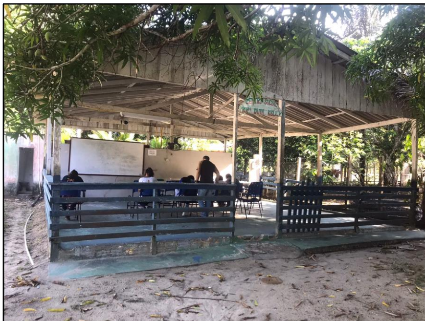
Figura 13 - Sala de aula improvisada denominada de "curral" pelo MP/AM
